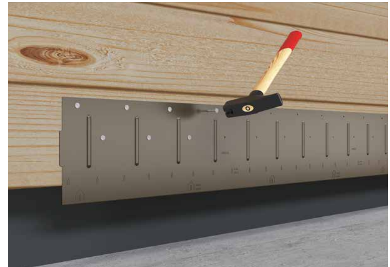
Bild 59 • Startskena - Montering
