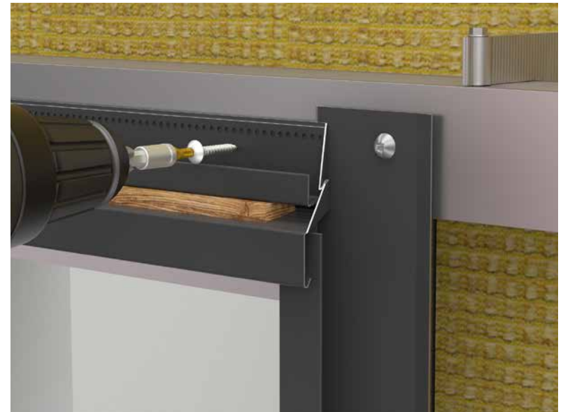
Bild 102 • Montering perforerat bleck överliggare
