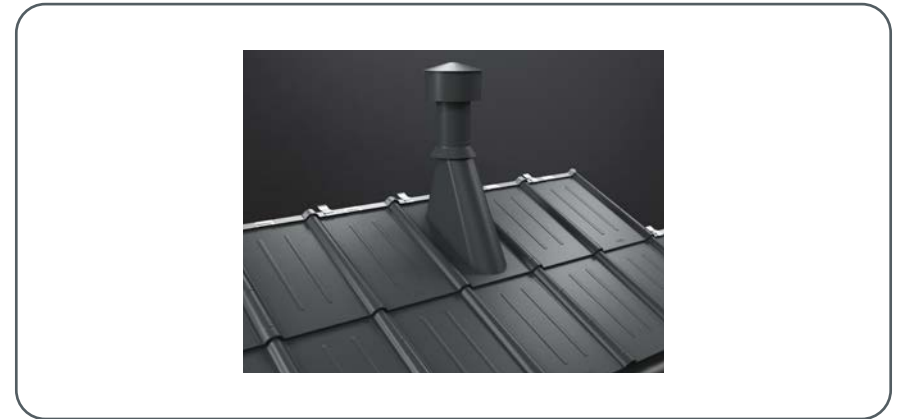
Bild 115 • Infattningsplatta och ventilationsrör – montering
