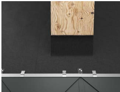
Bild 111 • Taklucka – särskilt förfarande vid takromb 29 × 29 och 44 × 44
