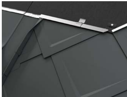
Bild 109 • Infattning takfönster – särskilt förfarande vid takromb 29 \times 29 och takromb 44 \times 44
