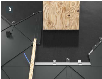
Bild 106 • Skorstensbeslag – takromb 29 × 29 och 44 × 44 – sidostycke
